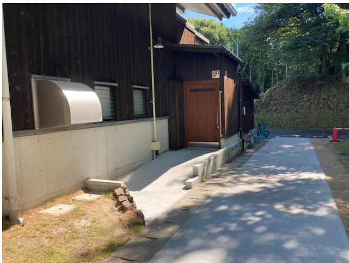
多目的トイレを新設しました
